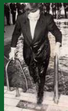
Nass gemacht: Bürgermeister Josef Antpöhler springt im Anzug ins neue Schwimmbecken. Foto: Heimatverein
