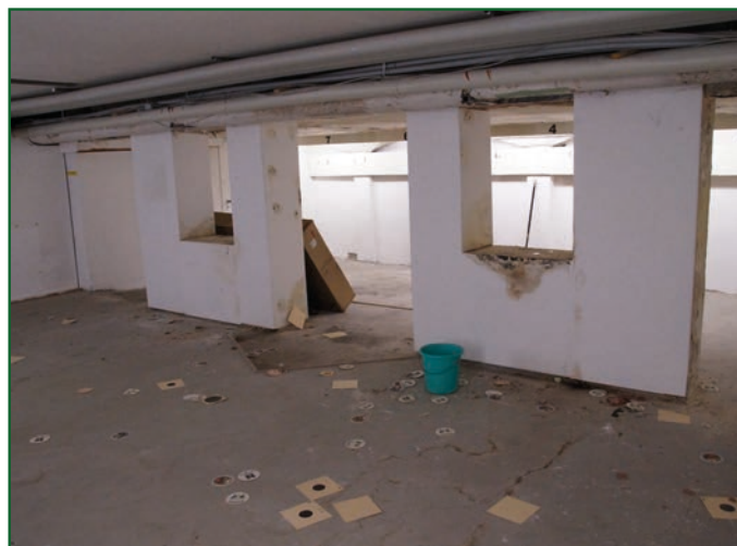
Geräumbauarbeiten bis hin zu einem der ehemaligen Schießkeller.
